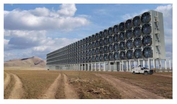
Conception d'un capteur de CO2 « Carbon Engineering » qui capturerait collectivement environ un million de tonnes de CO2 par an, soit l'équivalent des émissions annuelles de 250 000 voitures. / SOURCE: Ingénierie du carbone : https://energypost.eu/extract-co2-from-our-air-use-it-to-create-synthetic-fuels/
